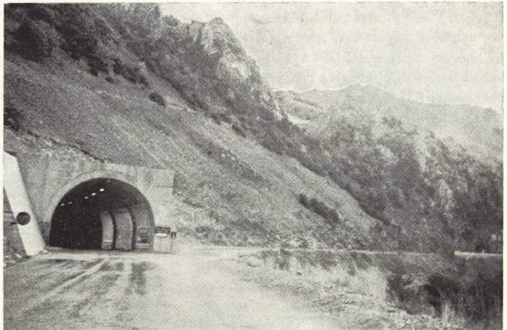
Entrée sud : l'ancienne entrée se trouve à l'extrême droite.
