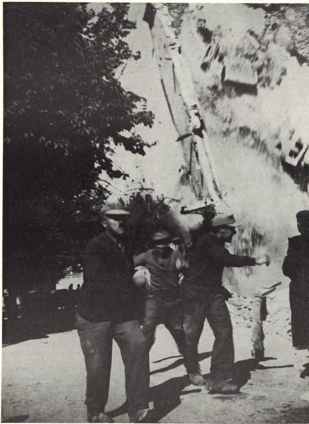
A La Chapelle-en-Vercors, après la Libération, on fait sauter les immeubles incendiés pour les reconstruire.
